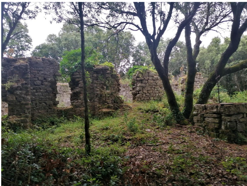
Mur sud, vue vers l'est, cliché Uhde-Stahl 6/2022
