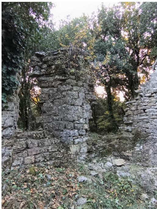
Mur sud, fenêtre 2 nd travée et entrée clichés Uhde-Stahl, 10/2025
