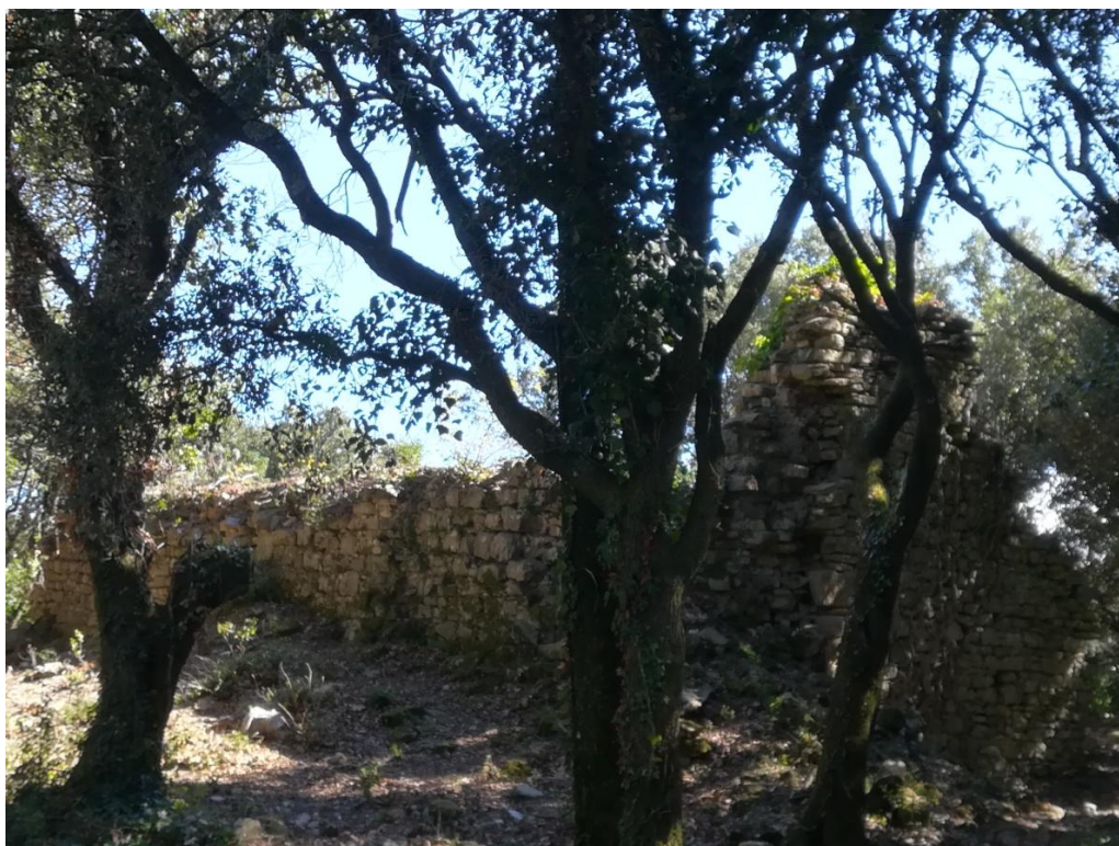
Mur nord, vue vers l'est, cliché Uhde-Stahl 9/2021
