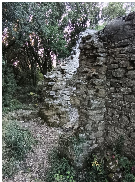
Mur sud, contrefort à côté de l'entrée
