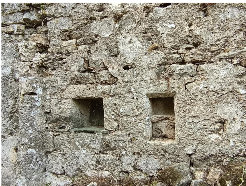
Niches mur nord, 3eme travée, cliché Uhde-Stahl 10/2025
