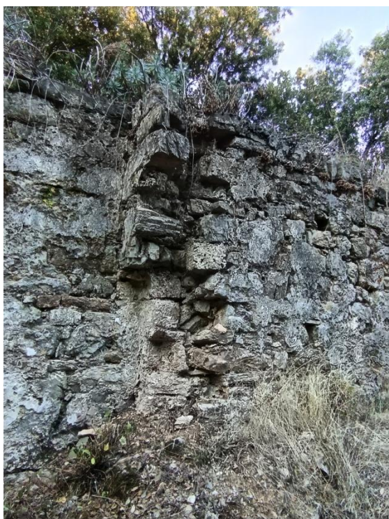
Nef, mur nord, restes d'un arc triomphal Clichés Uhde-Stahl 10/2025
