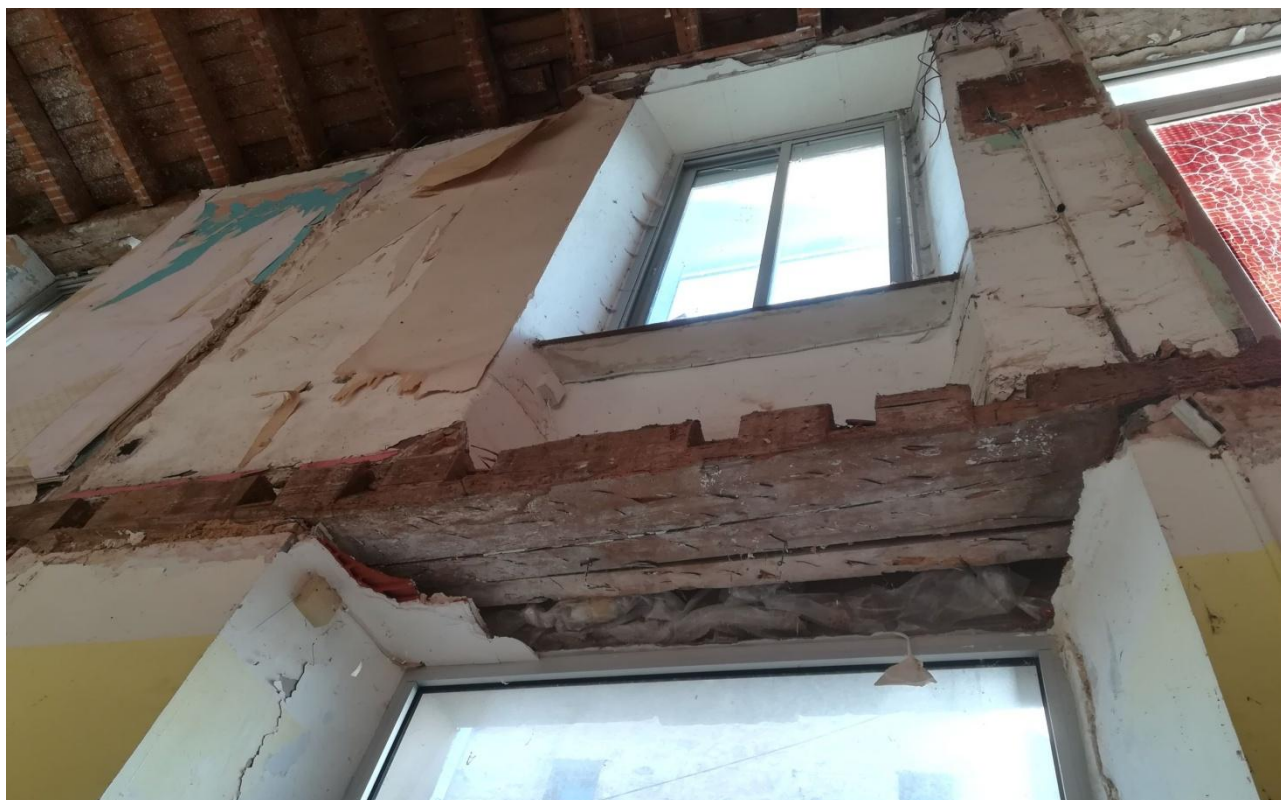
Fig. 10 - Façade principale, vue de l'intérieur, détail avec la poutre inférieure © Cliché Uhde-Stahl
