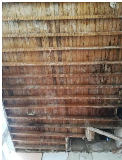
Fig. 14 - Plancher sous toiture, 1/2024 © Cliché Uhde-Stahl
