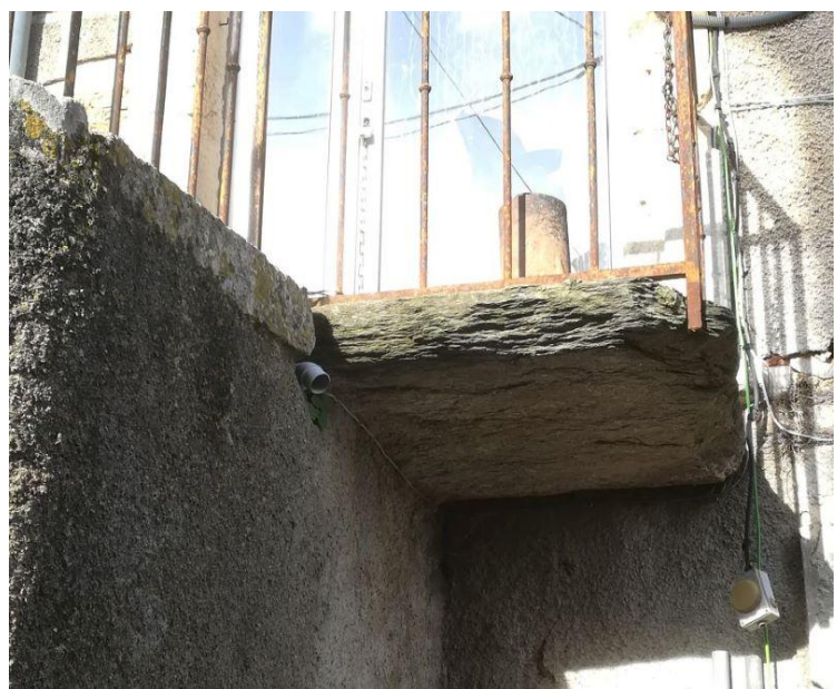
Fig. 5 - la dalle soutenant l'entrée à l'étage © Cliché Uhde-Stahl
