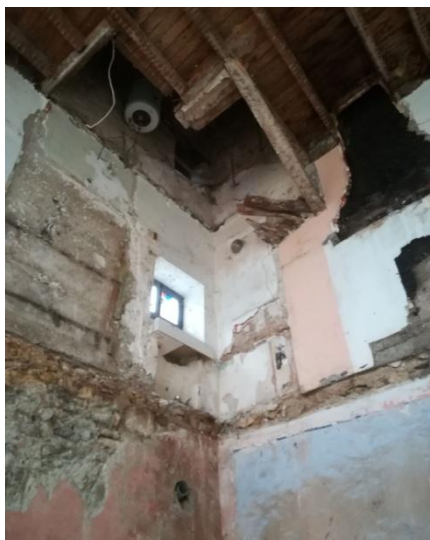
Fig. 13 - Étage, 1/2024 Angle route des Bergers/maison voisine © Cliché Uhde-Stahl
